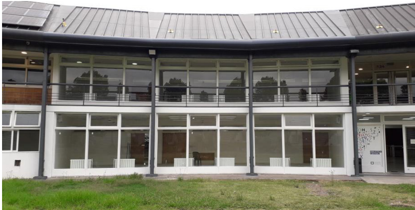
Edificio Corona del Tornavía -ETAPA V OBRA NUEVA 1.156 m 2
